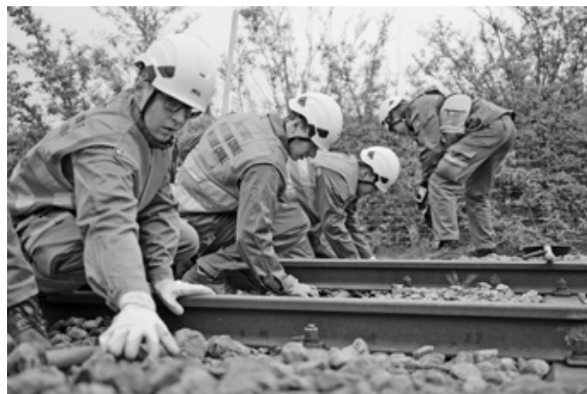
Leitungsbau «WK-FU» Führungsunterstützung, Bazenhaid
