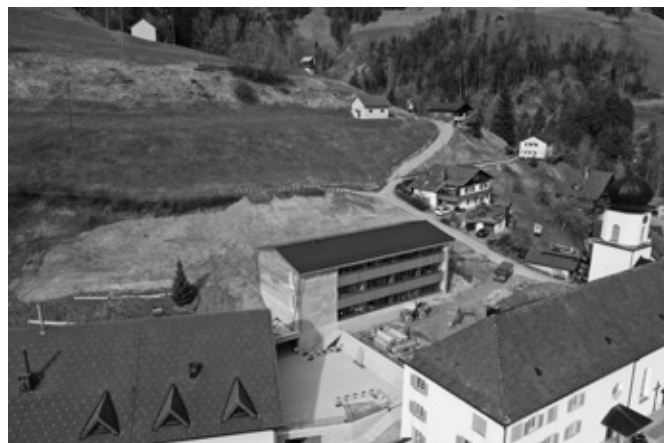
Stand Schulraumerweiterung Libingen 21. Februar 2024
