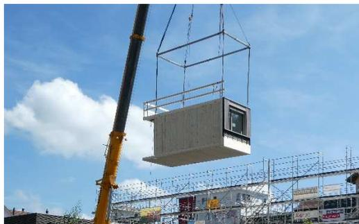
**Aufrichte beim Ärztezentrum.** Der Bau des Ärzte-zentrums an der Bachstrasse geht nun zügig voran. Heute werden die ersten Module als weitgehend fertige Zimmer eingesetzt. Die Module werden mit Spezialtransporten angeliefert und mit einem riesigen Autokran in den Bau eingefügt. Das geht recht schnell.
