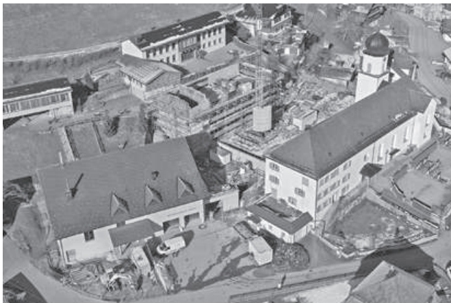
Stand Bauarbeiten 9. Februar 2023
